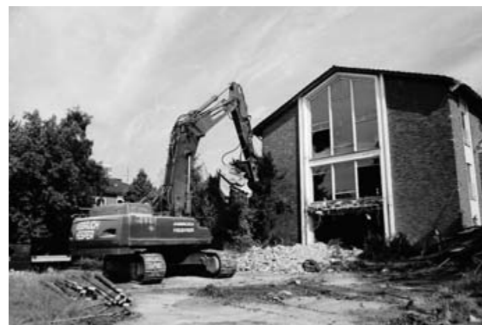
Abriss des ehemaligen Haus Anna
